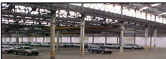
Almacenamiento bajo techo
