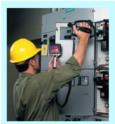
Inspección y toma de fotografía Infrarroja Fuente: FLIR SYSTEMS
